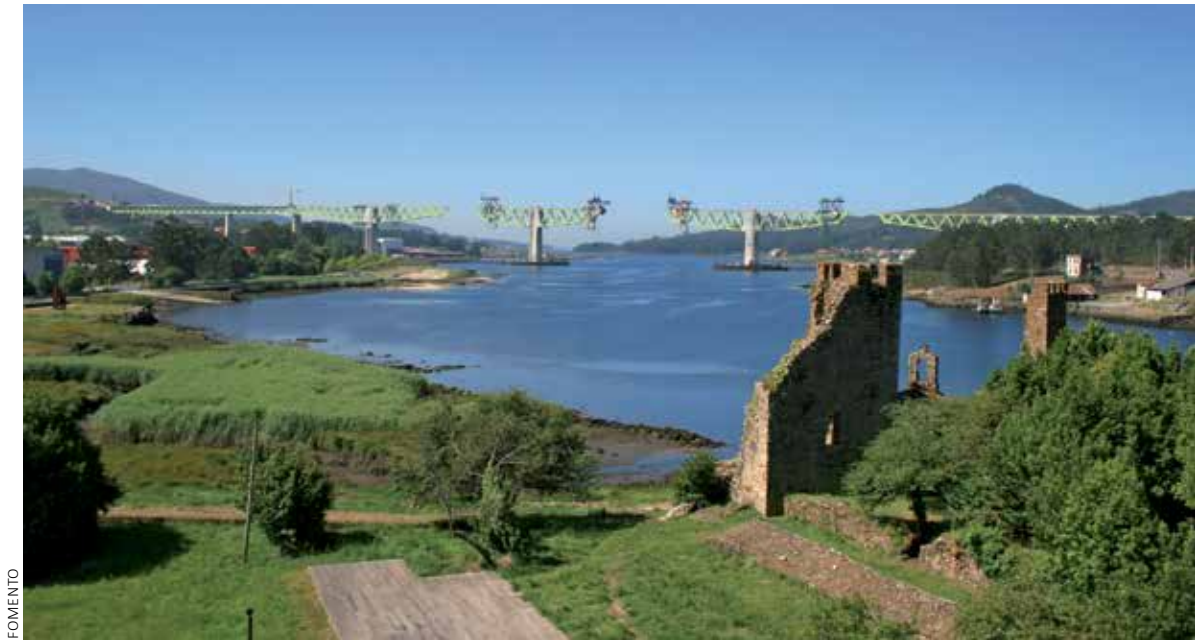
Construcción del viaducto sobre el río Ulla en el eje Atlántico de Alta Velocidad
